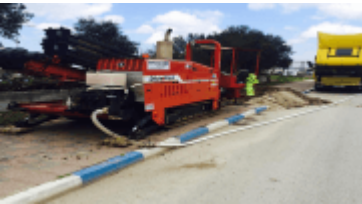
Topraklar Yatay Sondaj Tecrübesi
